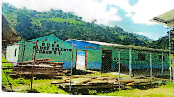
Foto 1: cambio de cubierta de lamina
