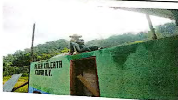
Foto 4: cambio de puertas
