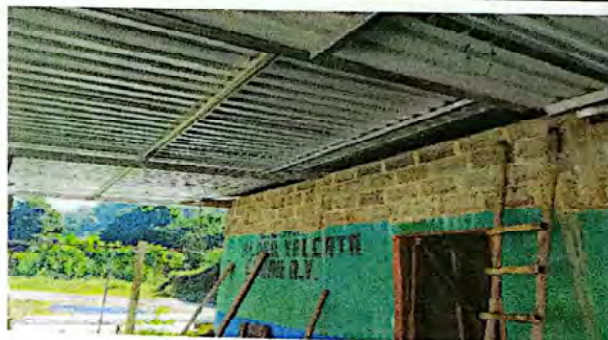
Foto 2: cambio de estructura de techo de madera a metal
