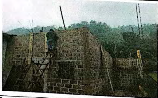
Foto 3: reestructuración de ventanas y puertas
